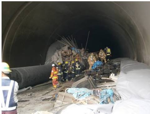
5/26 14:05 坑内作業状況
